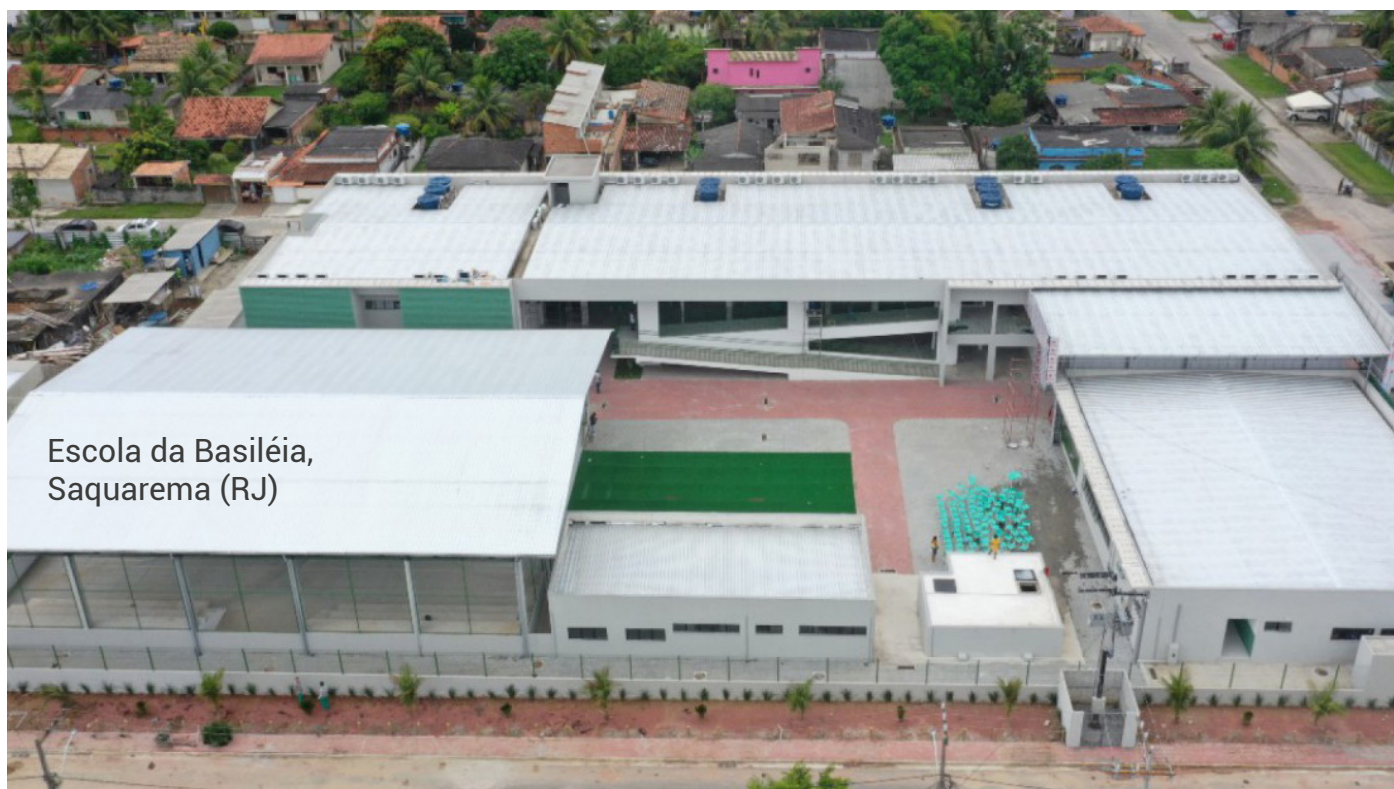
Obra de infraestrutura, Maricá (RJ)
